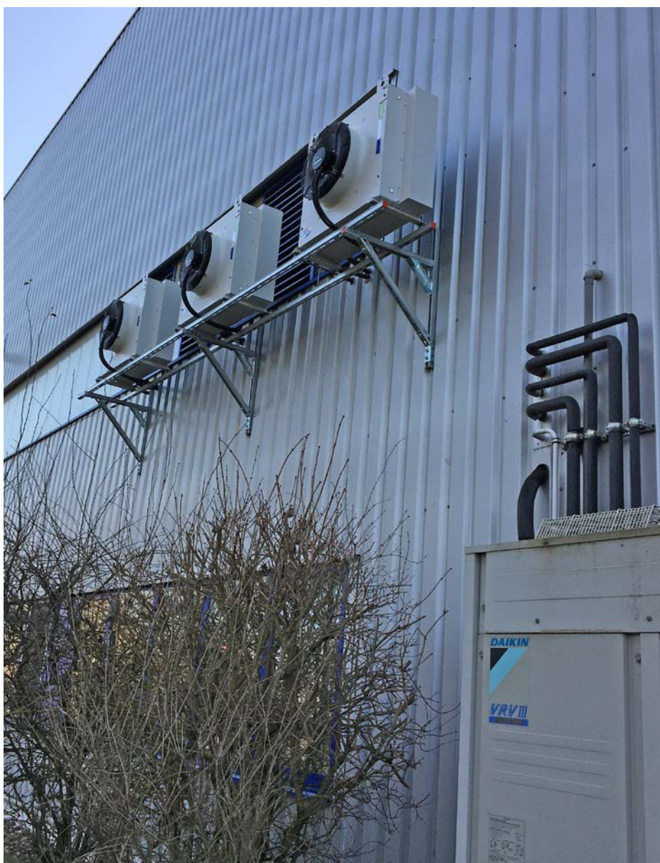
Die Verflüssiger konnten direkt an der Außenwand des Maschinenraums montiert werden.
