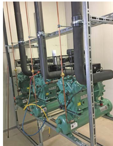
Die neue Kälteanlage nimmt Gestalt an.
