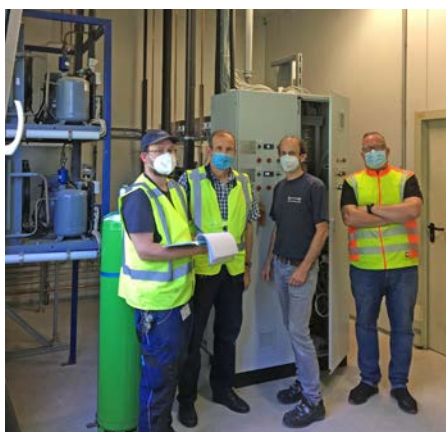
Abnahme der fertigen Kälteanlage im Maschinenraum (Anlage im Hintergrund), von links, Christopher Popp, Armin Klein, Ralph Rinck, Rene Lämmerrmann
