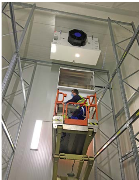
Montage der Ansaughauben
