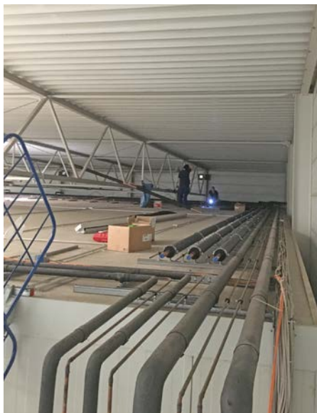
Montage von Leitungen und Rohren auf dem TK-Lager
